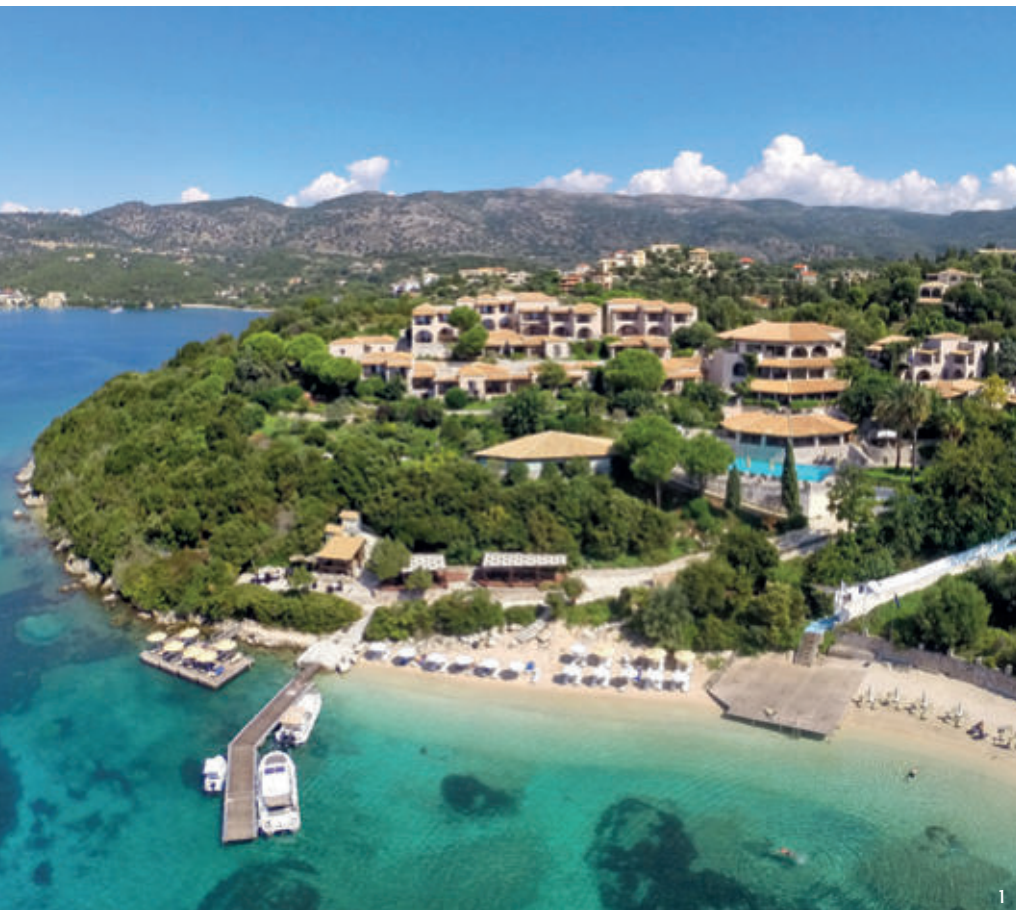
1 Ansicht von oben 2 Pool 3 Beispiel Suite
